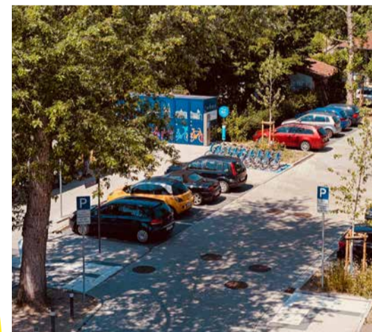
MOBILITÄTSSTATION WESTBAHNHOF ist seit 2024 fertig.
